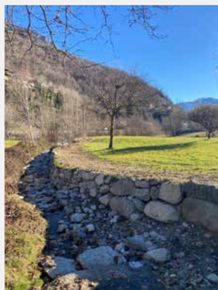
Rifacimento muro di sostegno Loc. Pratolungo
